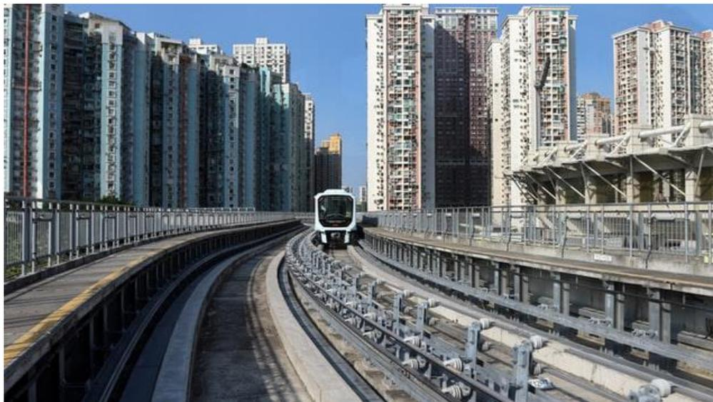
マカオ特別行政区政府は、「大湾区発展計画大綱」における、マカオと中国本土の都市間の高速度鉄道の利便性向上、交通インフラの相互接続の加速の実現のために、2021年2月にマカオライトレール(LRT)・トランジット横琴線延伸プロジェクトの建設を Nam Kwong (Group) Company Limited (南光グループ) に正式に依頼しました。マカオ LRT 横琴延伸線の主要構造は、高架橋、川底トンネル、及び2つの駅で構成されており、全長は約2.2km、そのうちトンネル部分は約900mとなっています。この路線は、マカオ LRT タイパ線の蓮花大橋駅に隣接する HE1 駅 (高架駅) を起点に、蓮花大橋の方向に沿って徐々に下っていき、川底トンネルで十字門水道を渡り横琴に入り、横琴イミグレーションの地下1階にある HE2 駅 (地下駅) が終点となります。
